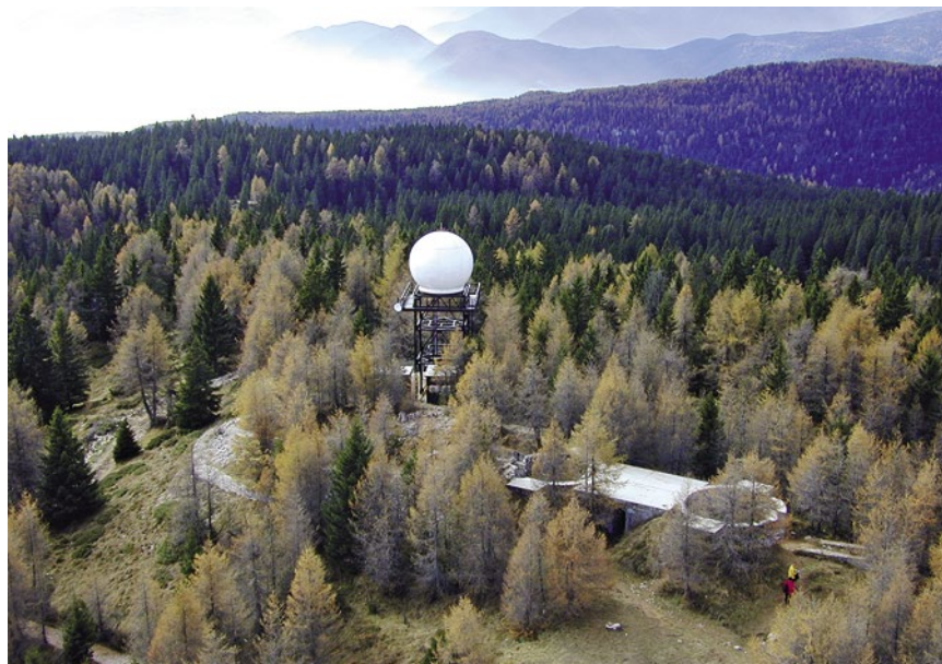
Niederschlagsradar auf dem Gantkofel oberhalb von Eppan.
